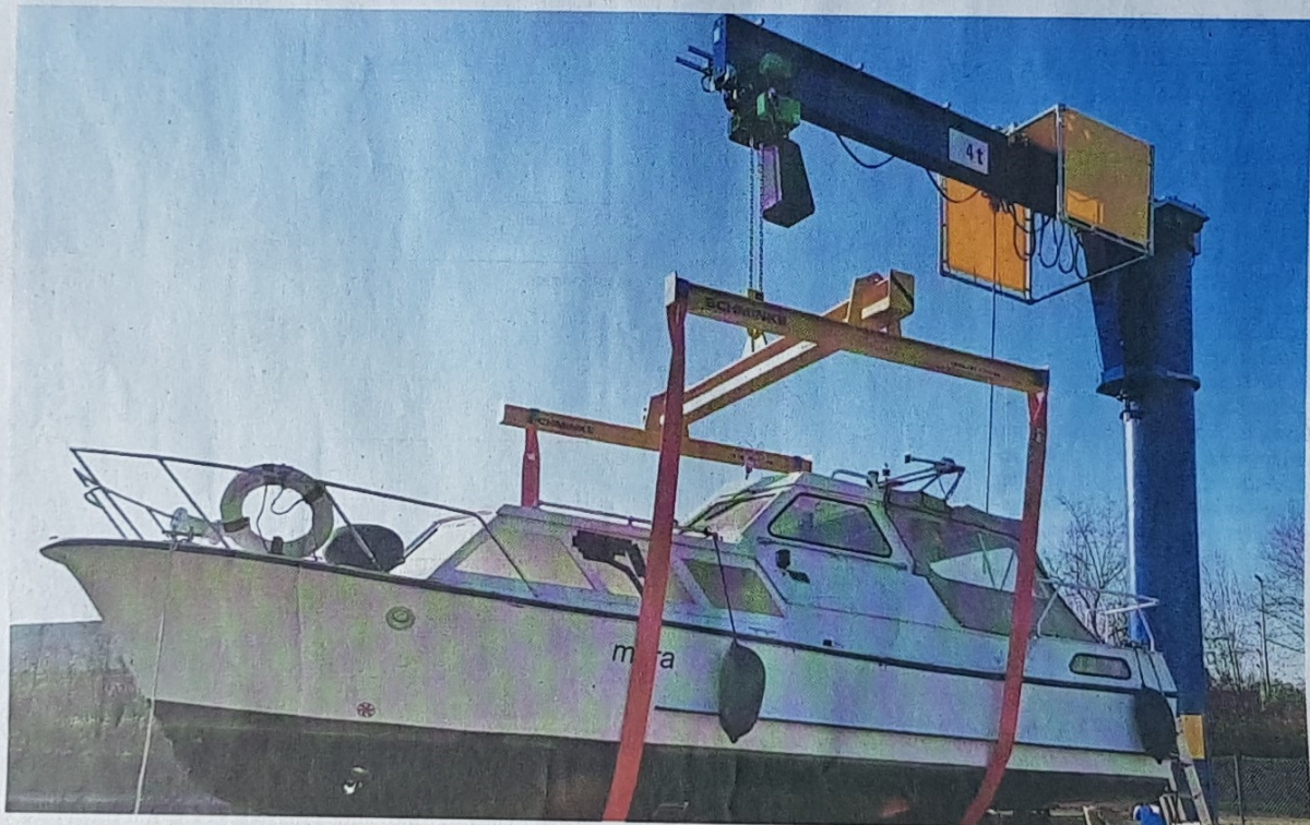
Mit dem neuen Kran können die Boote der Mitglieder ins Wasser oder auf den Trailer gehievt werden.
